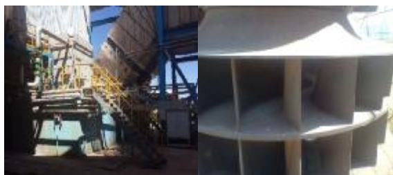
شکل (1): نمایی از داکتهای ورودی و ایملر فن دمنده هوای بویلر
